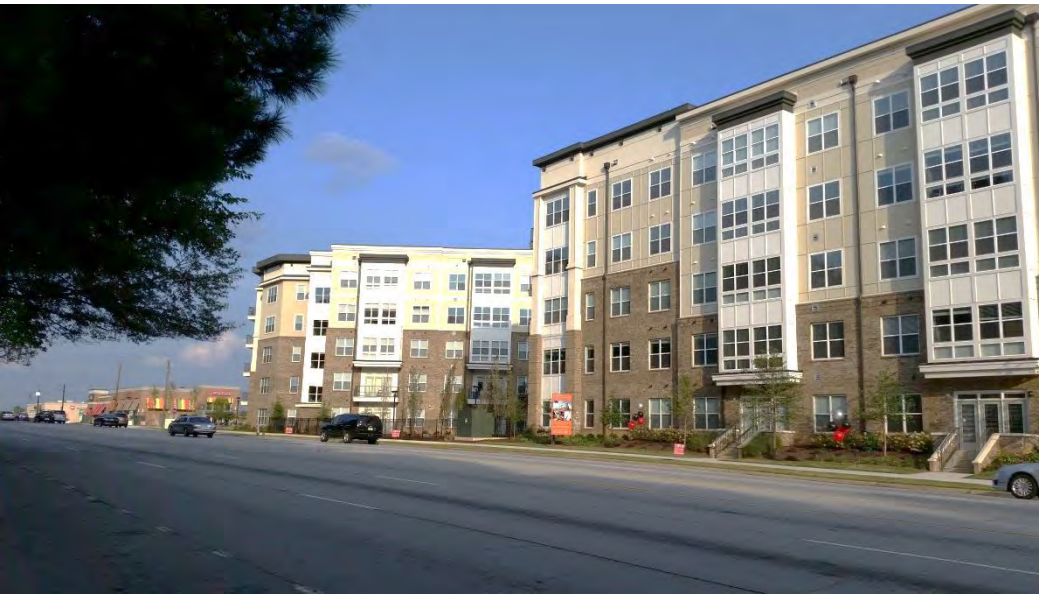
Scott Boulevard frontage
